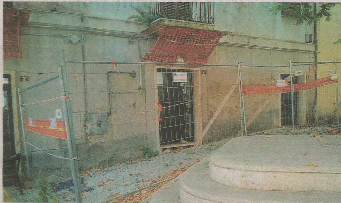
Uno dei tanti edifici di Montorio danneggiati dal terremoto del 2009
